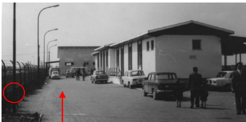
Fabbricato costruito in muratura della nuova aerostazione civile. (archivio: Giovanni Gaffè).
