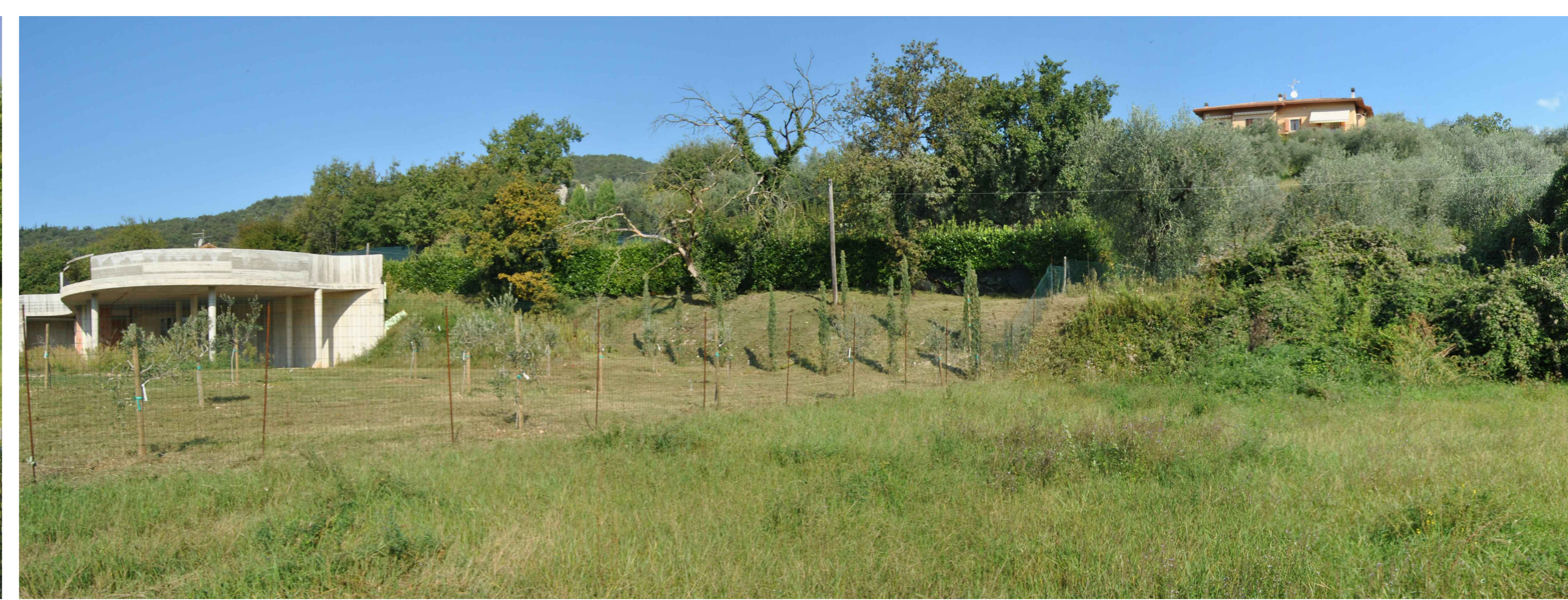
② Vista dall'area d'intervento verso il progetto del bicigrilli in fase di realizzazione
