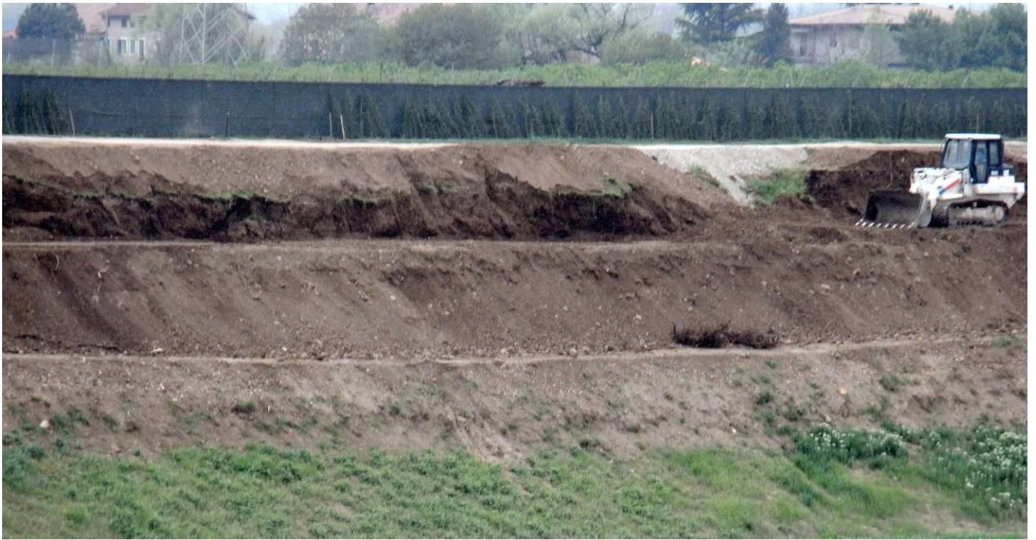
DETTAGLIO LATO OVEST - stesura di: Terreno vegetale limoso-sabbioso color marrone con ghiaia e rari ciotoli?
