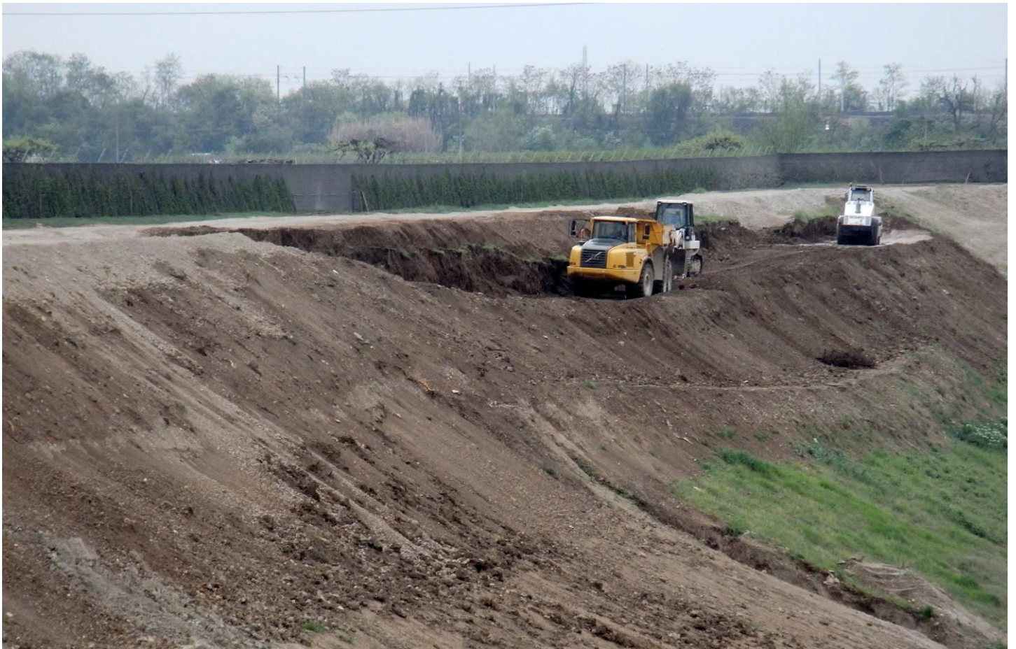
DETTAGLIO LATO OVEST - stesura di: Terreno vegetale limoso-sabbioso color marrone con ghiaia e rari ciotoli?
