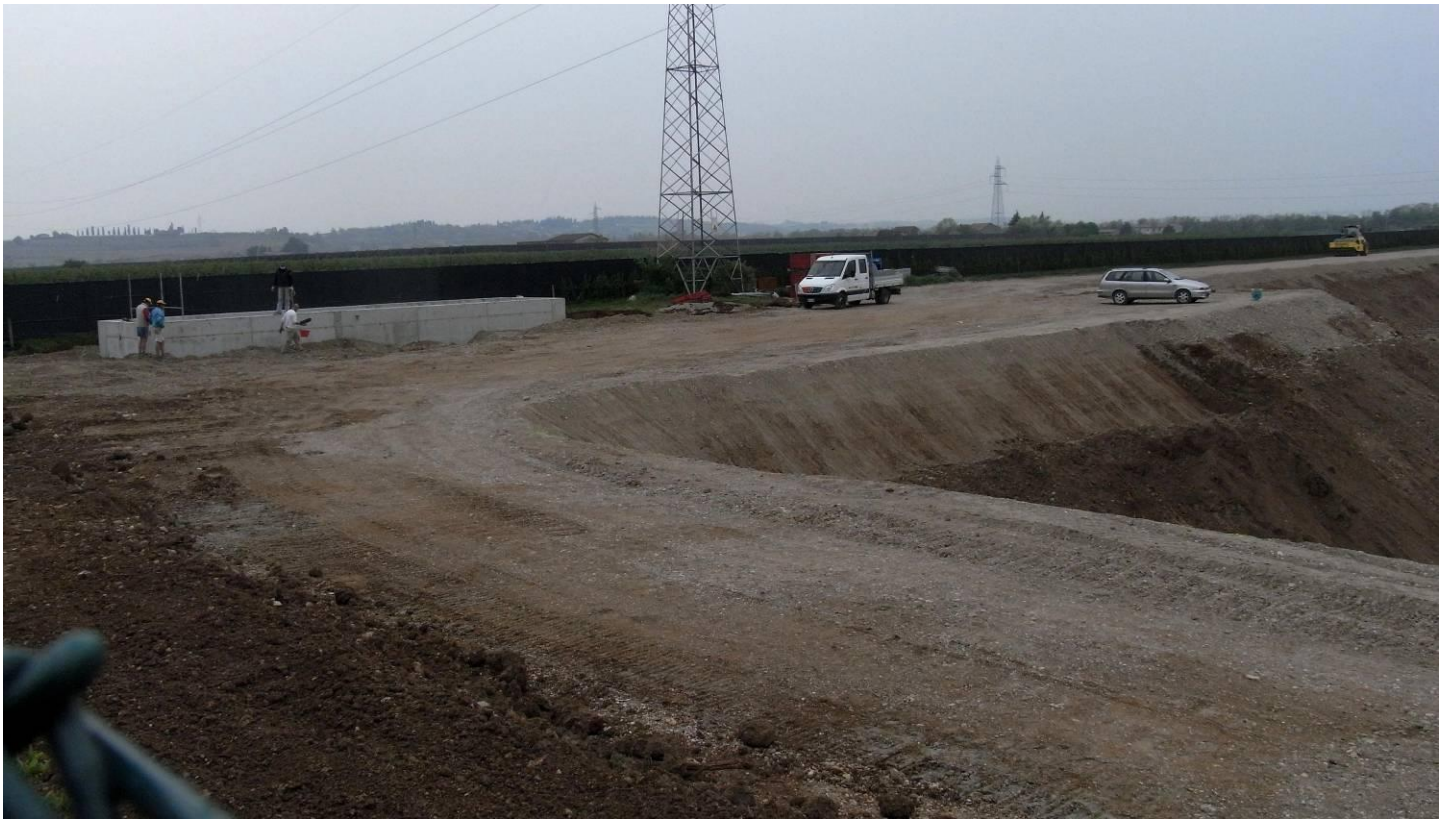
DETTAGLIO ANGOLO SU OVEST - stesura di: Terreno vegetale limoso-sabbioso color marrone con ghiaia e rari ciotoli che, se “asciutto” tende ad avere poi un colore simile alla ghiaia, ma che poi bagnato assume il colore marrone scuro, caratteristico di Terreno vegetale limoso-sabbioso color marrone con ghiaia e rari ciotoli ?
