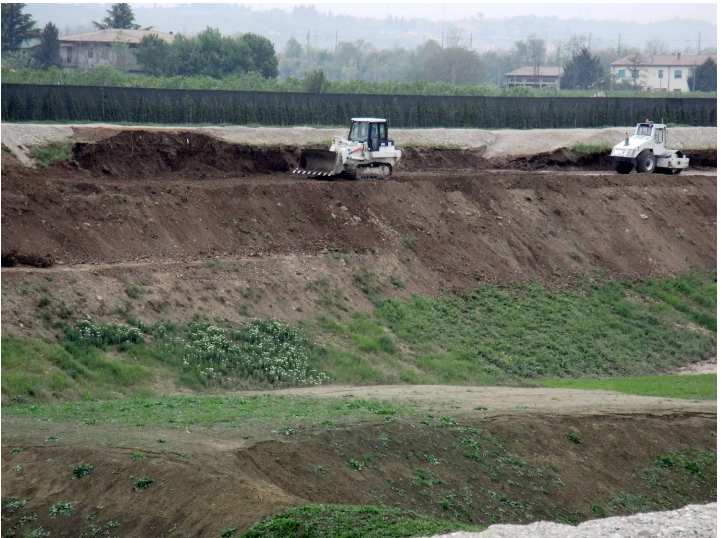
DETTAGLIO LATO OVEST - stesura di: Terreno vegetale limoso-sabbioso color marrone con ghiaia e rari ciotoli? In primo piano (parte in basso dell'immagine) i cumuli di argilla... portati "dentro" il Cantiere prima della nomina del Direttore dei Lavori. Nella parte centrale dell'immagine l'esistente parete dell'ex Cava Siberie che potrebbe essere ricoperta da limo di lavorazione della ghiaia inerbita poi col tempo. Nella parte superiore della foto risagomatura della parete dell'ex cava con: Terreno vegetale limoso-sabbioso color marrone con ghiaia e rari ciotoli?
