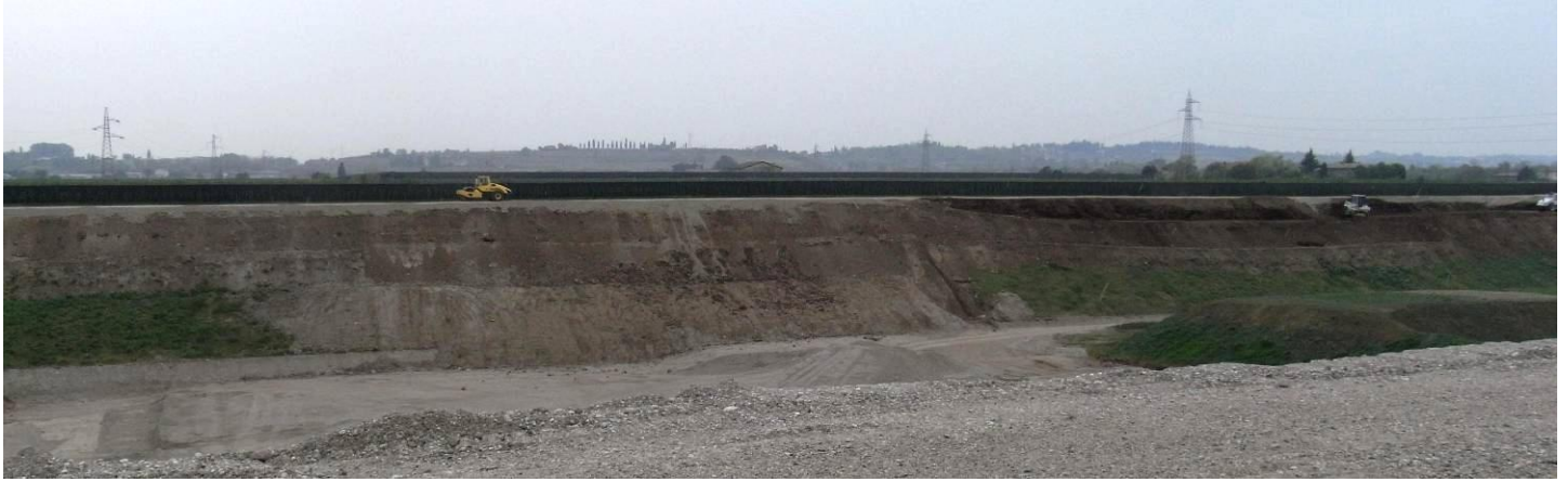
LATO OVEST - PARTE NORD
