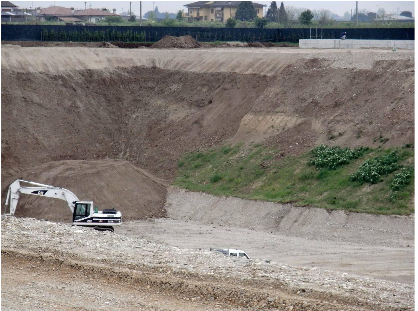
ANGOLO TRA LATO OVEST E LATO SUD
