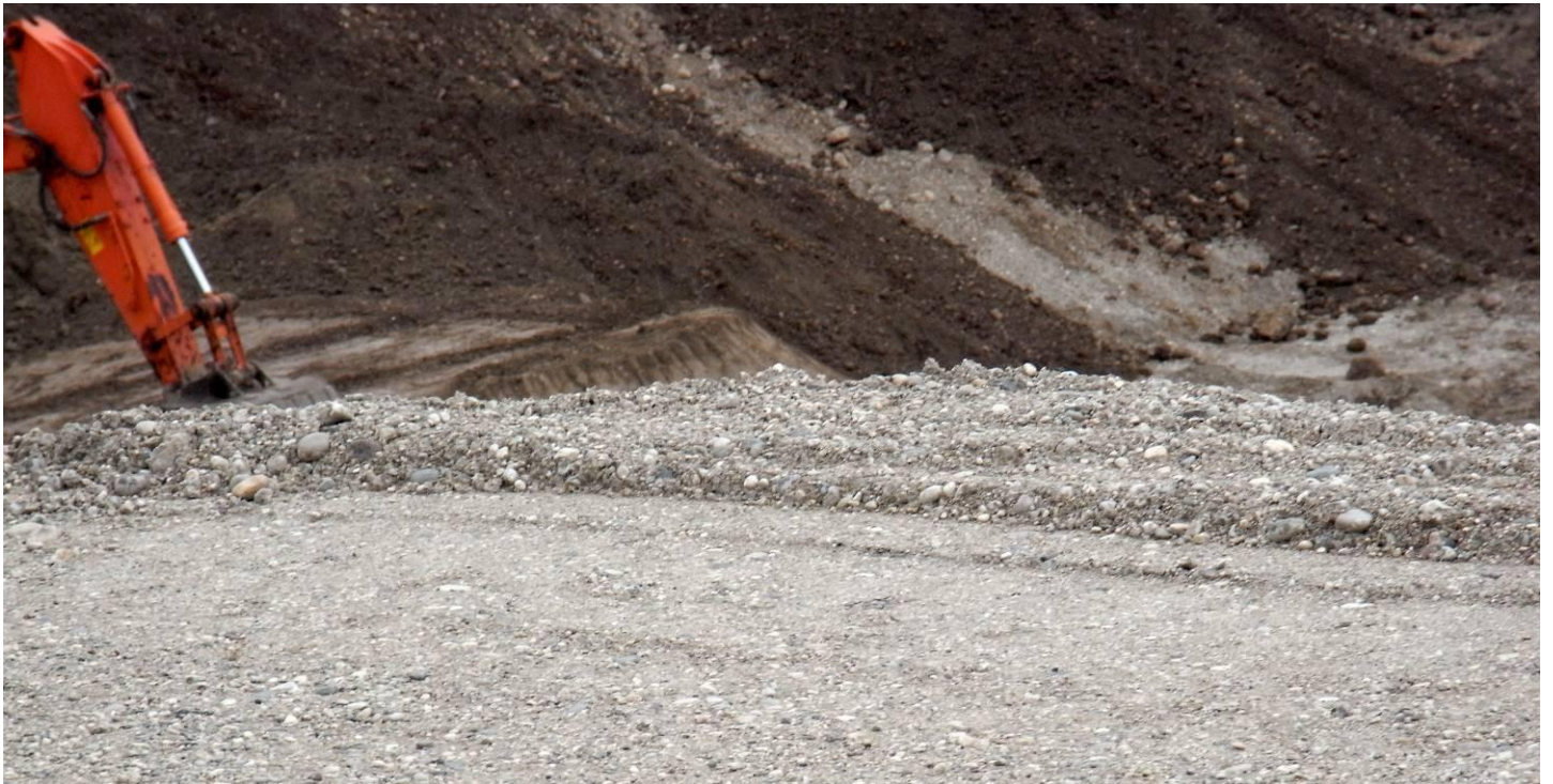
DETTAGLIO LATO SUD - stesura di: Terreno vegetale limoso-sabbioso color marrone con ghiaia e rari ciotoli?
