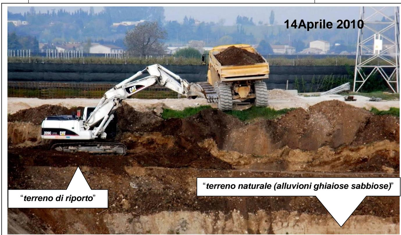
Era necessario scrivere questa NOTA prima di segnalare quanto riportato nel verbale dell'ARPAV relativo alla parete Ovest, di cui la sopra immagine sopra riportata evidenzia la struttura quella di “**terreno di riporto**” e quella di “**terreno naturale (alluvioni ghiaiose sabbiose)**”. Diversi ???.
