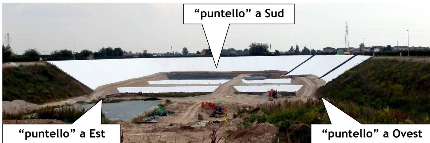
Considerato che i “**puntellamenti**” sono stati eseguiti utilizzando la **ghiaia di proprietà comunale** e che questi **apparentemente sembrano** avere una **sezione di larghezza** di circa **10 metri** e un’altezza di circa **5 metri**, per una **lunghezza** di circa **100 metri** è evidente che... solo per i “**puntellamenti**” delle pareti Est e Ovest e il 50% di quella a Sud... è stata utilizzata una... “**significativa**” quantità di ghiaia.
