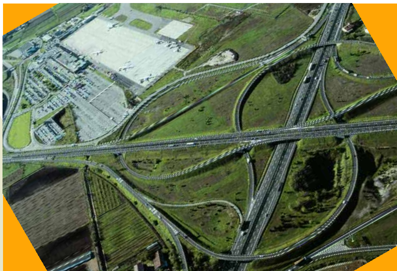
Veduta aerea delle infrastrutture viarie e aeroportuali presso Caselle
