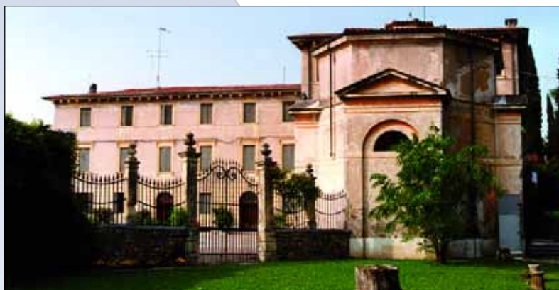
Villa Venier: primo intervento di restauro
