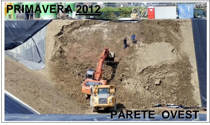
E se le pareti della VERA Discarica di Sommacampagna "collassano", l'unico motivo è che sono state male realizzate e utilizzando materiali non idonei: "Terreno Vegetale" riportato su "Limi di Lavorazione della Ghiaia" sulla cui tenuta sia ad infiltrazioni d'acqua che ad aventi sismici, il sottoscritto ha seri dubbi, che dovrebbero essere attentamente valutati da esperti "super partes".
