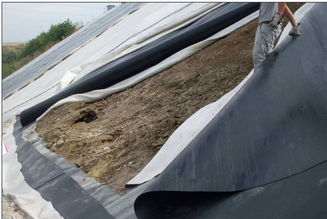
Figura 2 – Sollevamento dei lembi dopo il taglio dei teli alla base della sponda est del Lotto n. 2.
