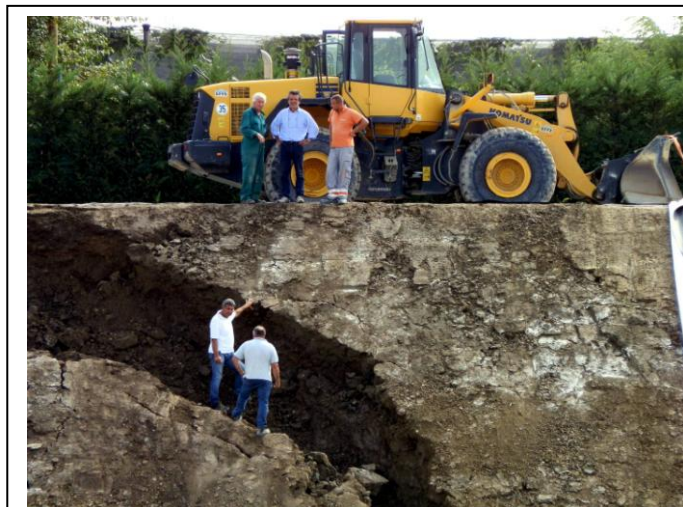
Lungo il confine Est c’è questo canale d’irrigazione
