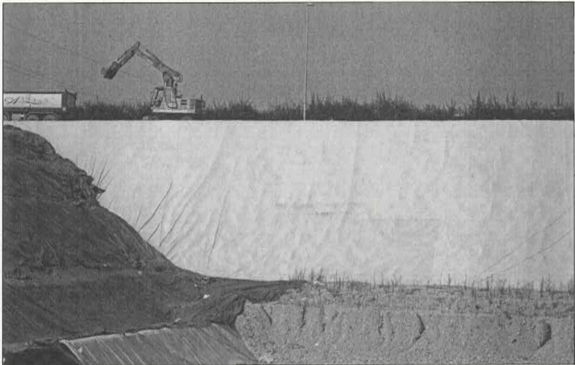
Figura 11 – Sponda ovest tra il Lotto n. 1 (a sinistra, in parte coperto dai teli) e il Lotto n. 2 (a destra).
